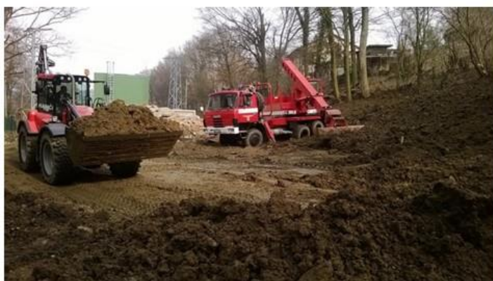
Částečná demolice objektu – T 815 6x6 UDS 114a
