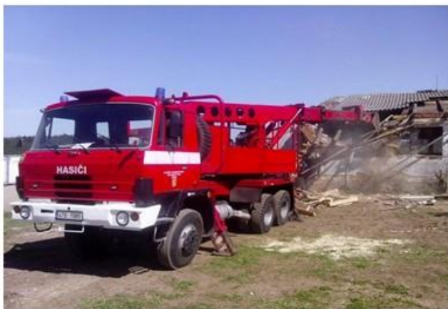
Částečná demolice objektu – T 815 6x6 UDS 114a
